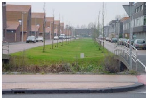
Bovengrondse infiltratievoorziening in Leidsche Rijn, Utrecht
