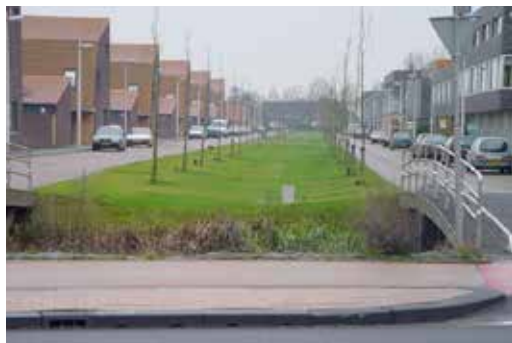
Bovengrondse infiltratievoorziening in Leidsche Rijn, Utrecht
