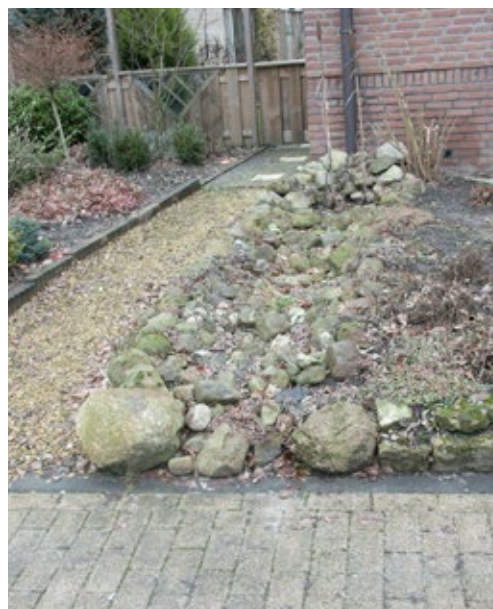
Oppervlakkige afvoer naar openbare voorziening
