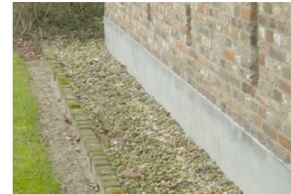
Opvang van hemelwater in grindsleuf direct naast woning
