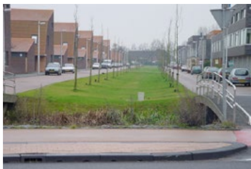
Bovengrondse infiltratievoorziening in Leidsche Rijn, Utrecht
