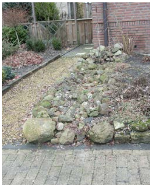
Oppervlakkige afvoer naar openbare voorziening
