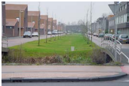
Bovengrondse infiltratievoorziening in Leidsche Rijn, Utrecht
