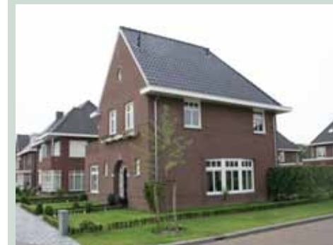
gevels: donkere baksteen; dak: donkere pannen
