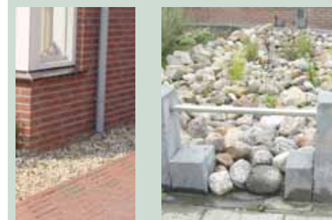
zichtbaar infiltreren van regenwater op eigen terrein
