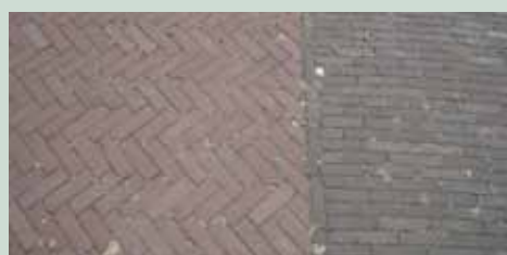
rijbaan en berm; afwijkende kleur en bestratingspatroon
