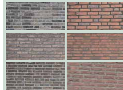
gevels: donkere, bruine/bruinrode baksteen
