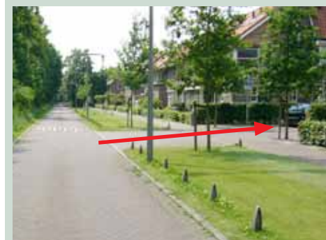
parkeerkoffer gaat op in straatbeeld (door ligging tussen woningen, achter voorgevel)
