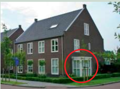
hoekwoning met dubbele orientatie; zijgevel met erker
