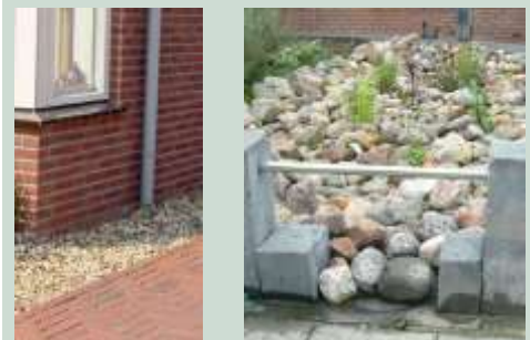
zichtbaar infiltreren van regenwater op eigen terrein
