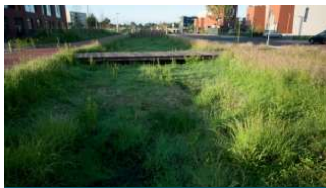
Bovengrondse infiltratievoorziening in de Piekenhoef
