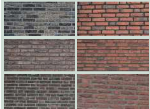
gevels: donkere, bruine/bruinrode baksteen
