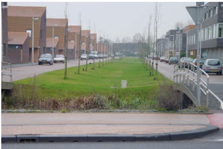
Bovengrondse infiltratievoorziening in leidsche Rijn, Utrecht
