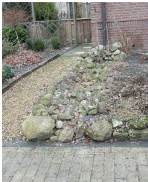
Oppervlakkige afvoer naar openbare voorziening
