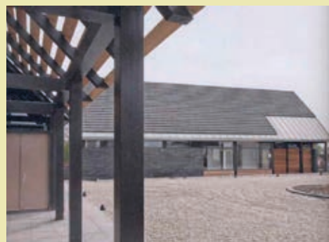
materiaal: combinatie van steen met hout en pannen met zink
