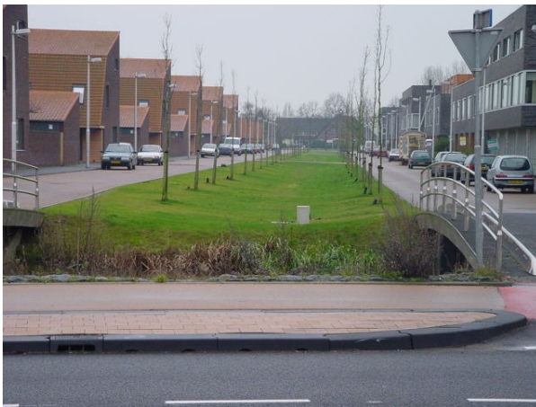
Bovengrondse infiltratievoorziening in Leidsche Rijn, Utrecht
